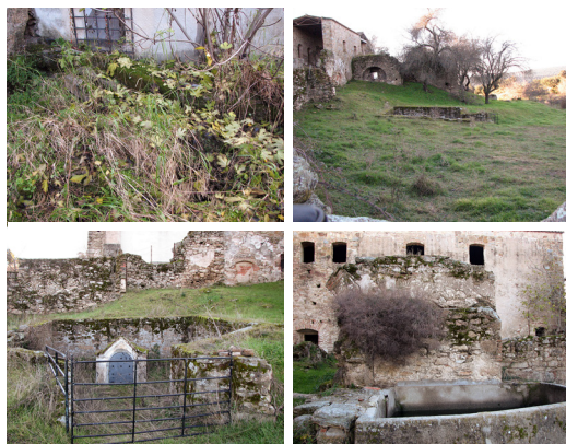
Figura 17. San Francisco. Belvís de Monroy. Canalón de piedra berroqueña. Situación del pozo cubierto con una caseta de obra. Estanque de la huerta.
