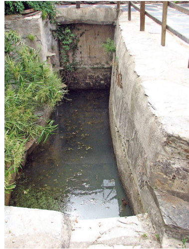
Figura 7. San Bartolomé de Alcántara. Actual Hospedería Conventual de Alcántara. Alcántara. Antiguas canalizaciones.
