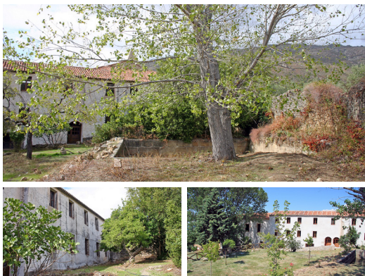
Figura 11. San Miguel. Actual Hospedería Conventual Sierra de Gata. San Martín de Trevejo. Fachada oriental. Antigua huerta del convento y su recuperación.
