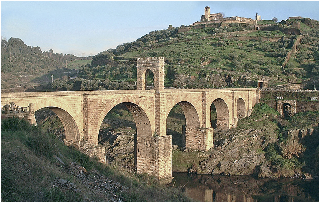
Figura 3. Puente romano de Alcántara.
