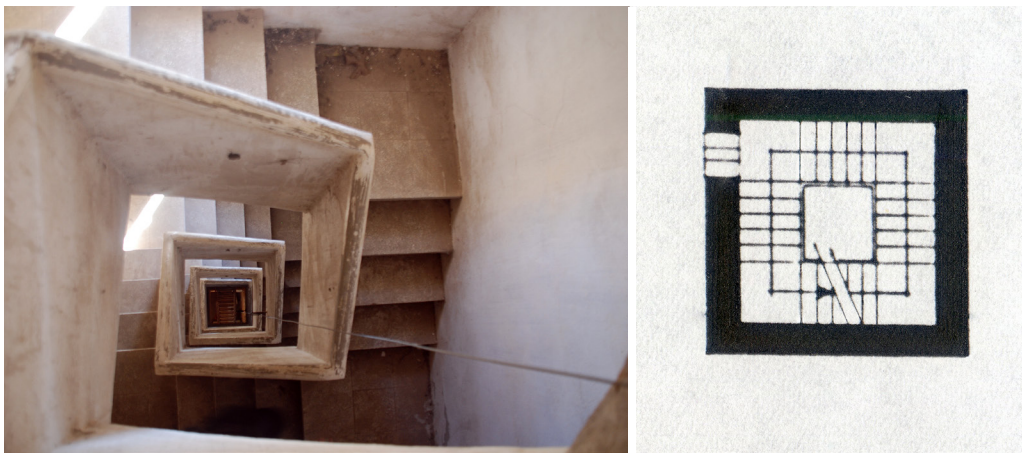
Figura 10. Interior y planta de la torre de Puelblonuevo de Miramontes.
