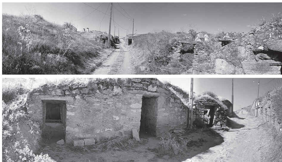
Vista exterior bodegas subterráneas. Granucillo de Vidriales
