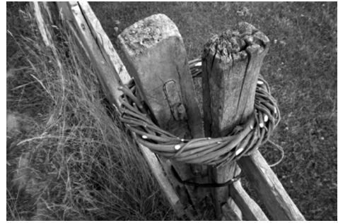
Foto nº 6. Cancillar montado parcialmente
