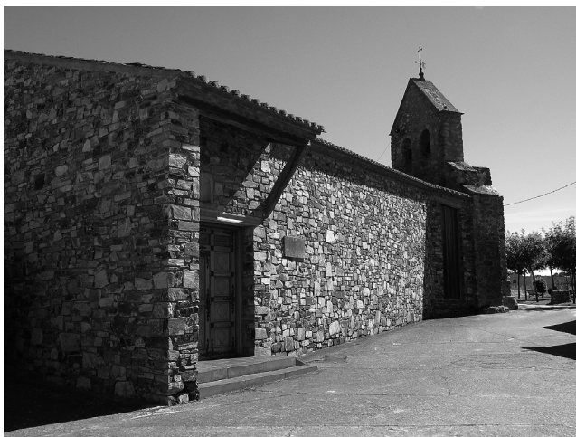
Fig. 7. Exterior del muro Norte
