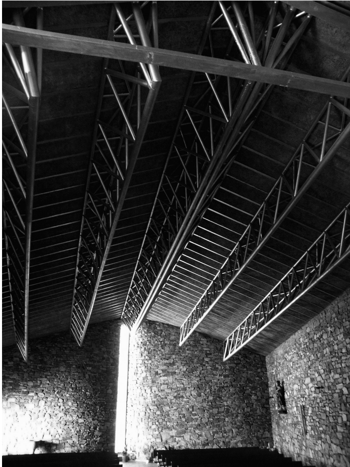
Fig. 10. Estructura de la cubierta
