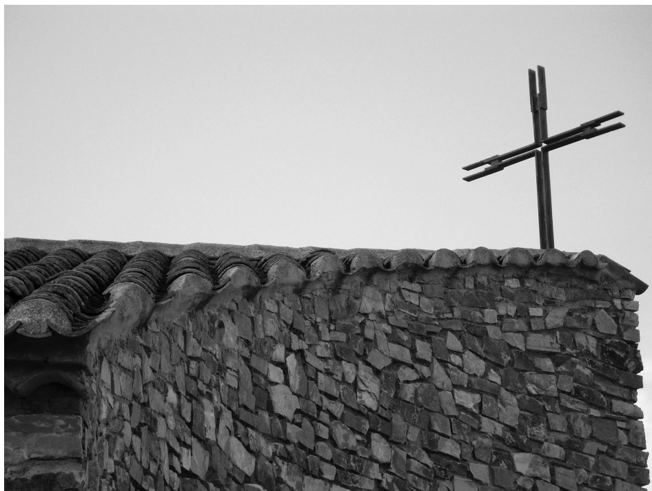
Fig. 13. Detalle de los canales que vierten por el muro.
