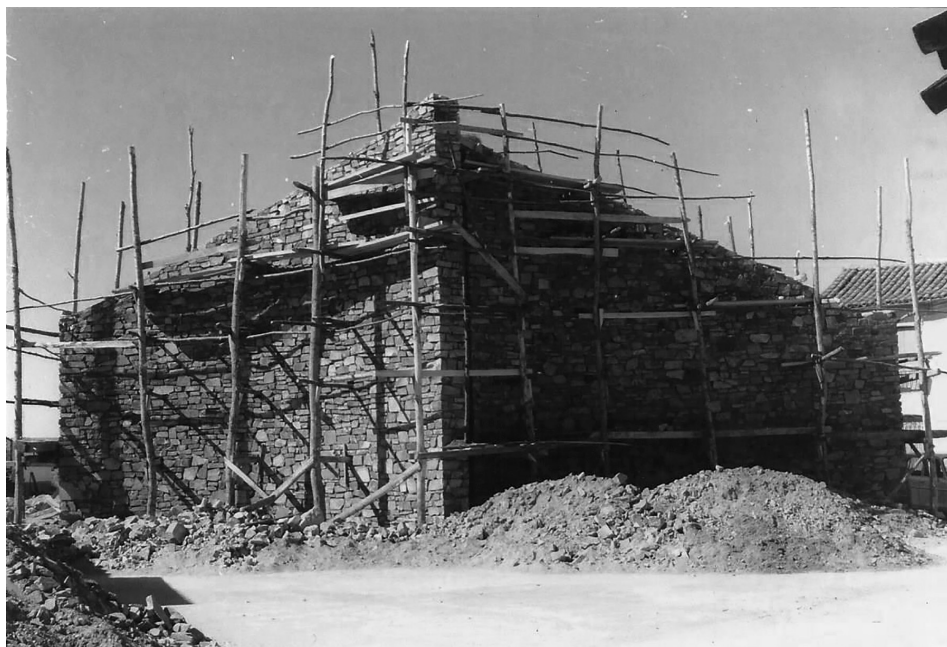
Fig. 10. Vista de la iglesia de Pumarejo en obras.
