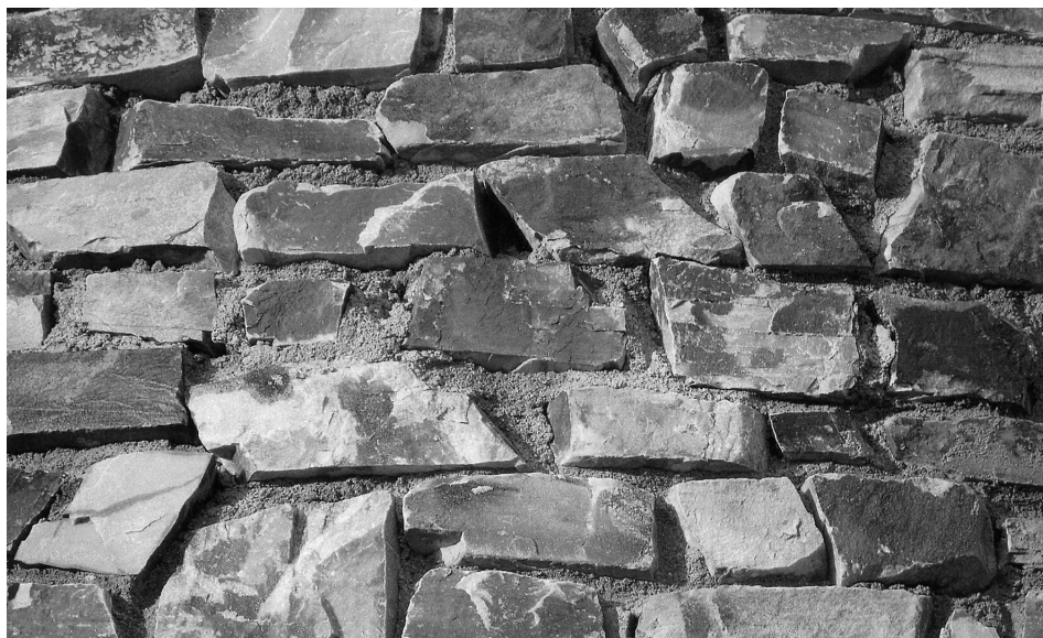
Fig. 14. Detalle de la mampostería exterior.
