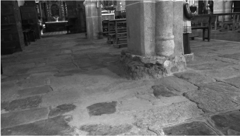
Pilar junto al muro norte, construido sobre la roca, que sobresale unos 15 centímetros. Foto: Julio Badenes.
