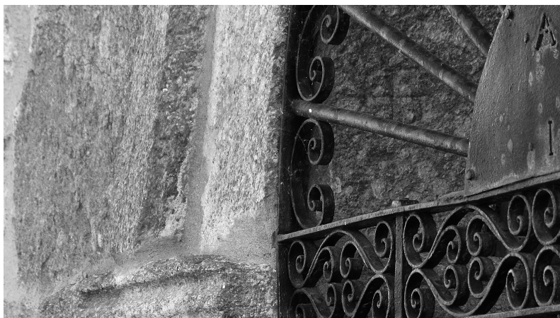
Marca de cantero medieval, con forma de cruz gamada o esvástica, (posiblemente siglos XII-XIII) en uno de los sillares o dovelas de la puerta románica situada en el muro norte, y que se usaba como puerta de acceso a la necrópolis o cementerio desde el interior del santuario.
