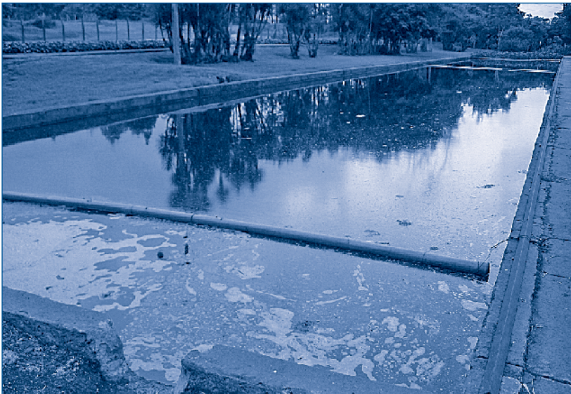
Figura 4. Laguna de tratamiento de aguas negras del ITCR.
