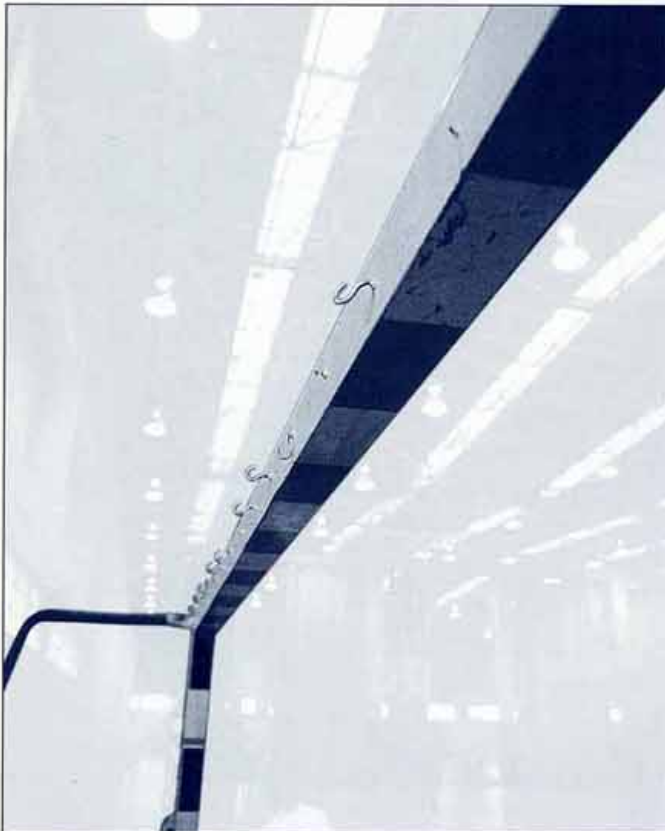
Posibles desgarros por incorrectos diseño y deterioros en las fijaciones de red de porterías.
