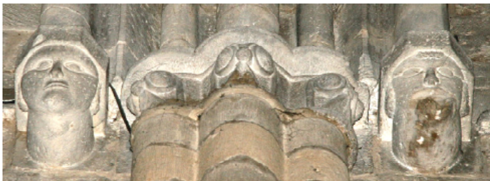
18. Santiago de Sangüesa. Ménsulas con cabezas de la nave central.
