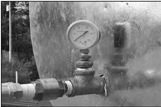
Figura 3. Fotografía ensayo de presión, detalle de manómetro ubicado en la entrada del tanque.
