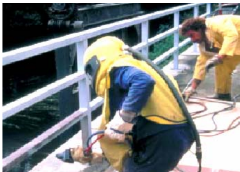
Figura 2. Estructura rociada térmicamente para protegerla contra la corrosión.
