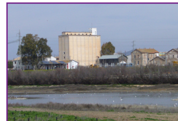
IMAGEN 1 Imagen 1. Vista del silo desde la laguna.
