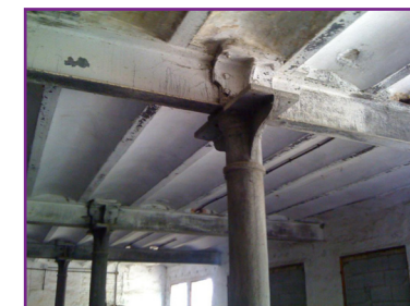
Forjado de bovedillas. Fuente: elaboración propia.
