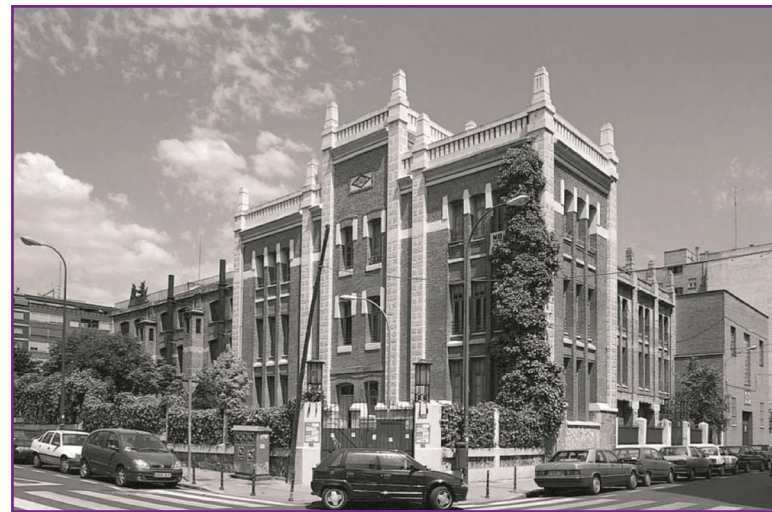
Imagen 3: Nave de motores en Pacífico Fuente: Memoria Histórica para el proyecto de Rehabilitación de la Antigua Central Eléctrica de Pacífico, Servicio Histórico COAM, 2006.
