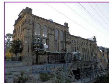
Imagen 4: Fachada aguas abajo de la central hidroeléctrica de Mengíbar (Jaén)
