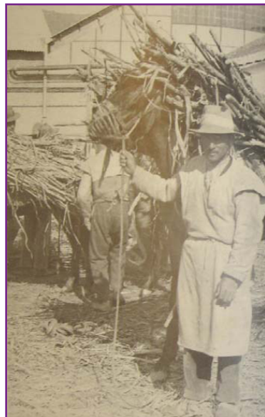
Figura 1: Arriero de acarreo cubierto con mandil de lienzo (AZUCARERA GUADALFEO)
