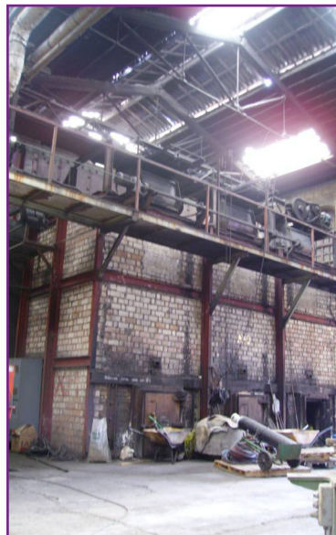
Figura 3. Conjunto de la caldera acuotubular C
