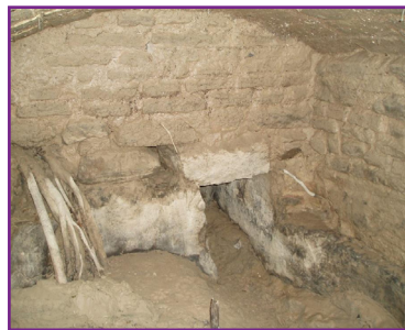
Figura 5: Interior del cárcavo de la Molina de Cabeza del Obispo, donde también puede observarse su bóveda en la parte superior. (Foto: J. López).
