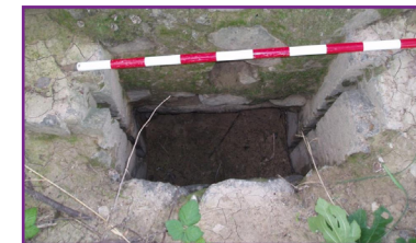
Figura 6: Uno de los saetines de la Molina de Cabeza del Obispo fabricado en el mismo muro del molino. Está regulado por unas compuertas -de ahí sus acanaladuras laterales- y situadas bajo el suelo del mismo. (Foto: J. López).
