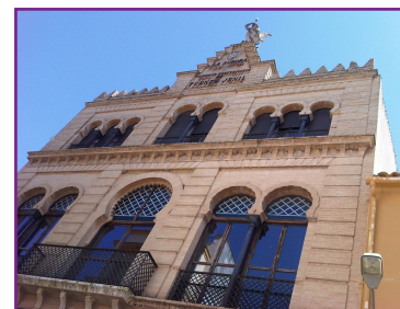
1. Fábrica de electricidad La Aurora, Puente Genil (Córdoba). Autora: Marta Santofimía.
