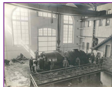
Montaje de la sala de máquinas de la Central de Madrid (1911).
