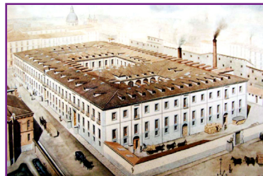
Antigua Real Fábrica de Aguadientes (1790) de Madrid y posterior Fábrica de Tabacos (1809).
