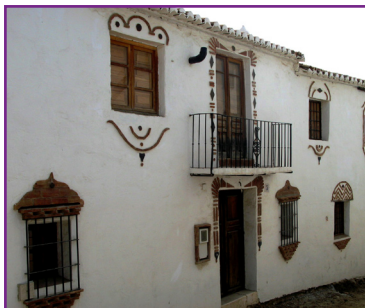
Real Fábrica de Naipes de Macharaviaya (fachada rehabilitada).
