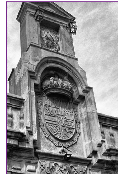
Casa de la Munición de Linares. A la derecha, detalle del escudo real.
