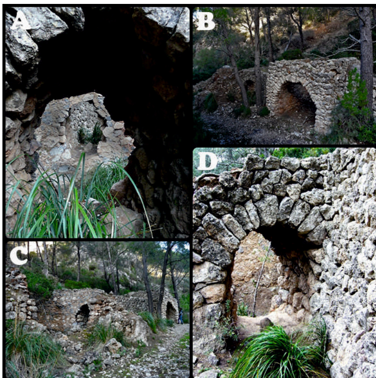
Figura 3: A) En la figura se puede apreciar las ventanas de carga y descarga; B) Cabaña posiblemente utilizada para guardar la leña que alimentaba el fuego del horno. La entrada está formada por un arco de medio punto no demasiado refinado; C) Horno de planta circular en el que es visible una de las aberturas laterales; D) Detalle del arco de medio punto de una de las aberturas laterales (Fotos J. Bermejo).
