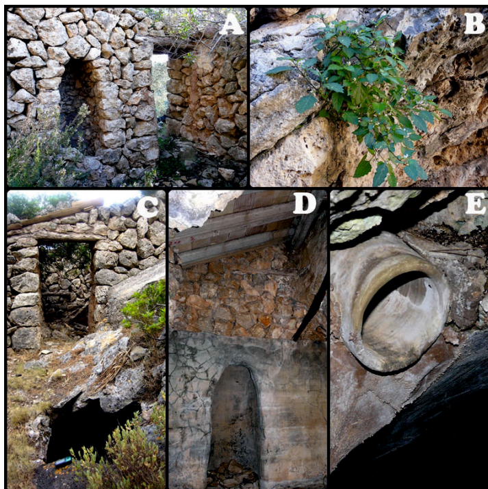
Figura 11: Aljub de sa Caseta. A) Lugar para la recogida agua del aljibe; B) Planta creciendo sobre la pared a la altura del tejado de la caseta; C) Entrada al aljibe y a la caseta; D) Extremo de la canalización por que caía el agua al aljibe (Fotos J. Bermejo).
