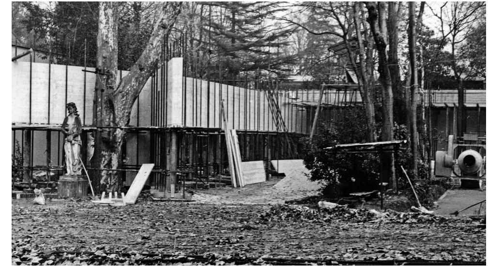
[7] Finalización del dintel y comienzo de hormigonado de las vigas de cubierta. Autor: Desconocido. Puede ser tanto Sverre Fehn, como Arne Neegard, 1961. Archivo Nacional de Suecia, sede Estocolmo.
