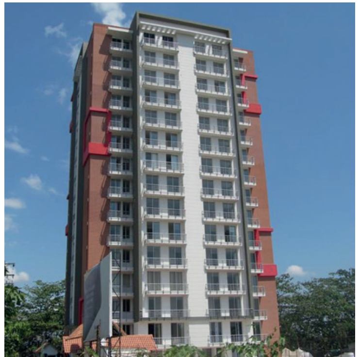
Figura 6 Edificio Morelia 3, sector de la terminal de transporte terrestre. Se observa el edificio Morelia 3, de 15 pisos.
