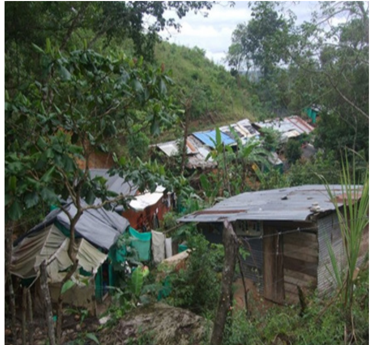
Figura 7. Aspecto del inadecuado uso y ocupación del suelo en el asentamiento de La Nohora. La fotografía indica aquí que se hace un mal manejo de las aguas residuales que se producen en las viviendas, que se asentaron sobre un terreno recientemente deslizado y que continúa desplazándose en el Presente.
