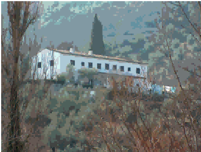
Estado actual del antiguo hotel, con una planta menos
