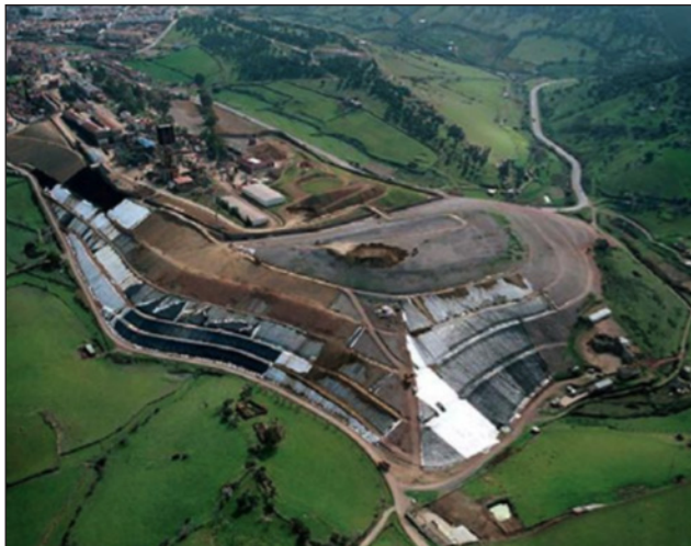
Figura 2 COLOCACIÓN DE GEOSINTÉTICOS SOBRE LA ESCOMBRERA DE ALMADÉN (MARZO DE 2007)
