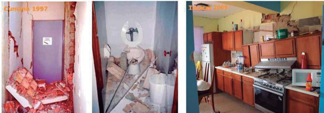
Figura 12: Riesgo de lesiones por caída de paredes
