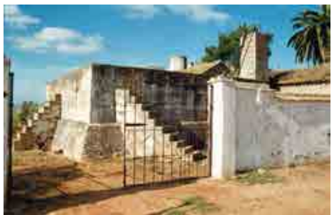
ALBERCA DE LA HACIENDA ESTEPA EN ÉCHJA. VISTA EXTERIOR
