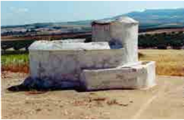
POZO EXTERIOR CON ABREVEDERO DEL MOLINO DE BORRAS EN OSUNA
