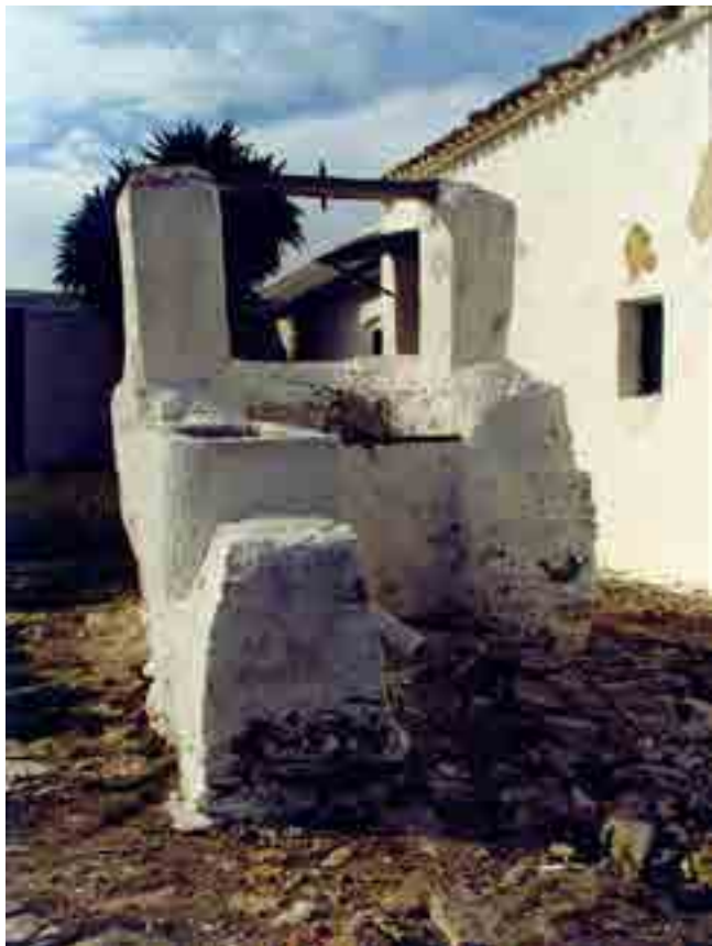
POZO EXTERIOR CON PILÓN ALTO DEL CORTIJO CALDERÓN EN OSUNA
