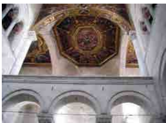
VISTA DEL CRUCERO CON LA BASE DE TROMPAS Y UN TECHO POSTERIOR DEL S. XVI
