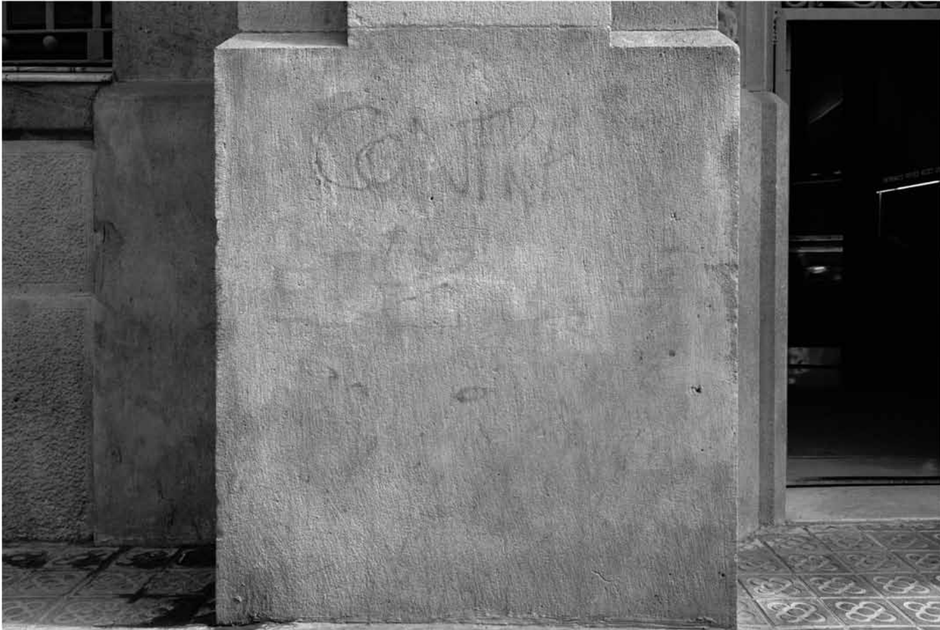
La Caixa (Via Laietana, Barcelona)
