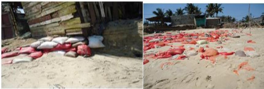
Figura 4. imagens reportando infrutíferas de tentativas de conter a erosão sobre a linha da costa
