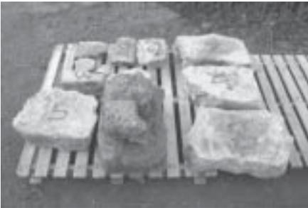
*Hammam* de c/ Santa Ana nº6. Losas de pavimento desmontadas y numeradas para su recolocación
