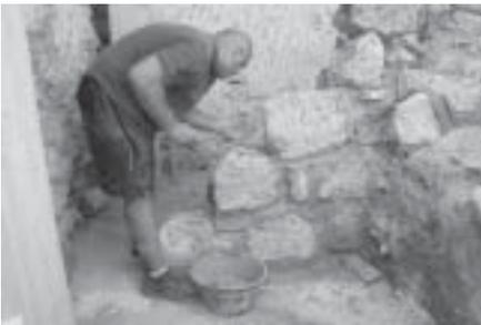
*Hammam* de c/ Santa Ana nº 6. Reconstrucción de muro desmontado para abrir pozo de cimentación
