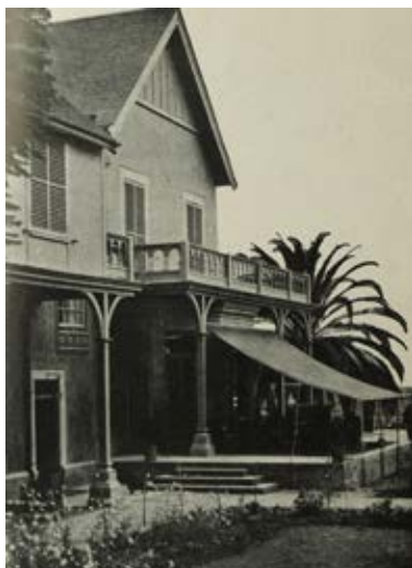
Fachada sur de la casa parcialmente reformada. 1928. Revista Cosmópolis .
