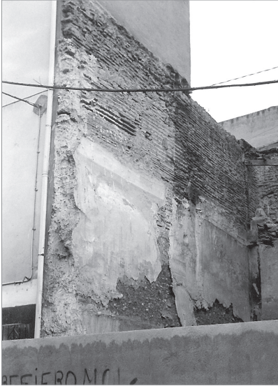
Foto 1. Calle Gobernador Bermúdez de Castro, 1. Pared oeste (año 1999). Sobre un muro de tapial, que llega hasta el primer piso, se levanta una pared de ladrillo en el segundo piso.
