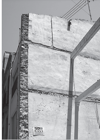
Foto 2. Calle Papa Luna, 16. Pared norte (año 1999) En la pared de la fachada, sobre el muro de tapial de la planta baja se levanta una pared de ladrillo en el primer y segundo pisos. La pared de mampostería del tercer piso corresponde a una elevación posterior del edificio, probablemente de finales del siglo XIX o principios del XX.
