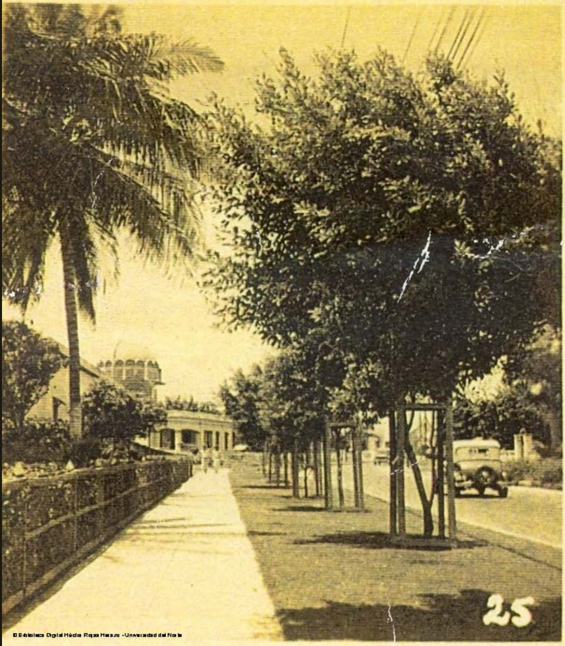
Foto N° 25. Barrio El Prado
