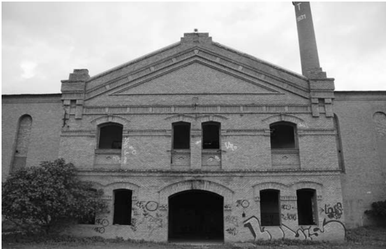
Estado actual del edificio
