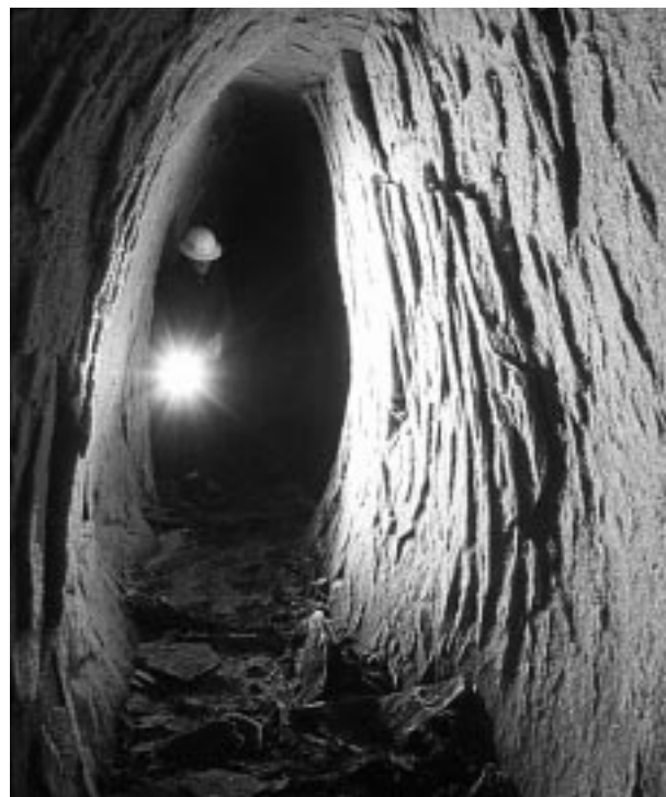
Figura 2: Transversal excavado mediante fuego en la mina Herzog Ulrich de Kongsberg. Las paredes están recubiertas de cristales de hielo. Foto: B. I. Berg, Museo de la Minería de Noruega.
