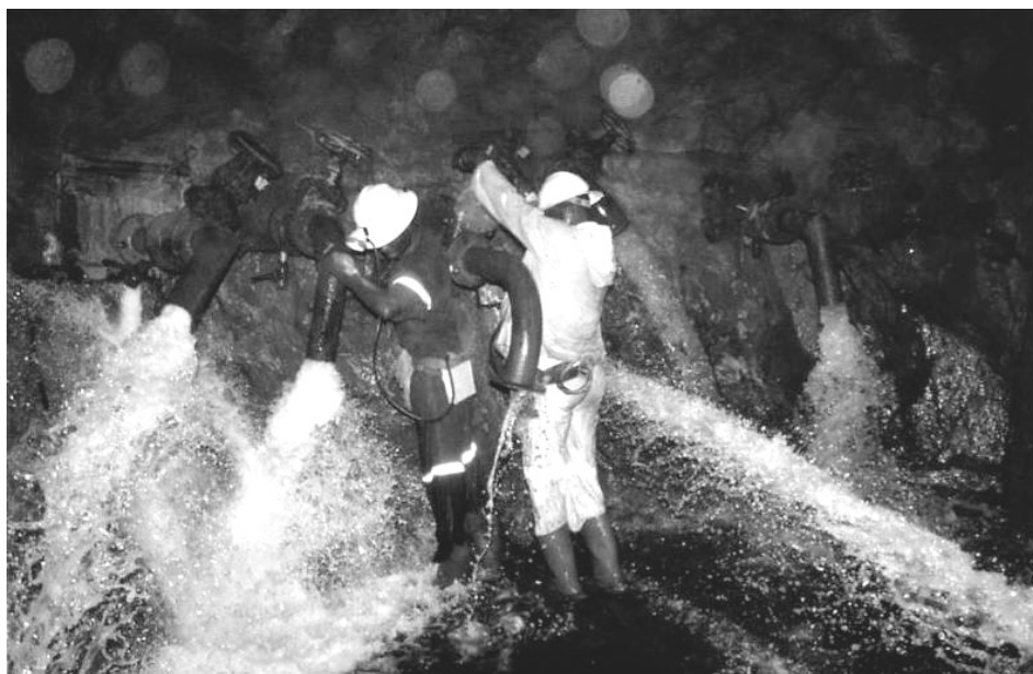
Figura 6. Drenaje de mina en frente de galería (Foto: Fernández Rubio, 2008).
