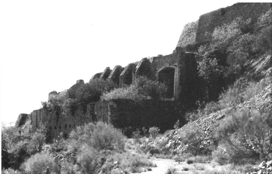
Figura 11. Lavadero de la Mina de Arrayanes (Gutiérrez Guzmán, 2007: 35).
