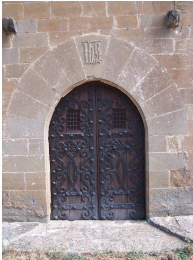
Puerta de arco apuntado ermita de San Babil. Clave con anagrama de Cristo en letras góticas y dos ménsulas en sillares, construcción principios del siglo XVI.(Fotografía: D.M.O. Octubre 2013).
