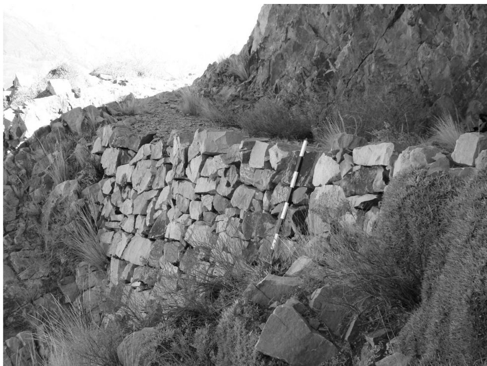
Figura 3. Arriba: tramo de camino incaico de 1,30 m de ancho con muro de retención lateral. Abajo: detalle de este muro de más de un metro de altura.
