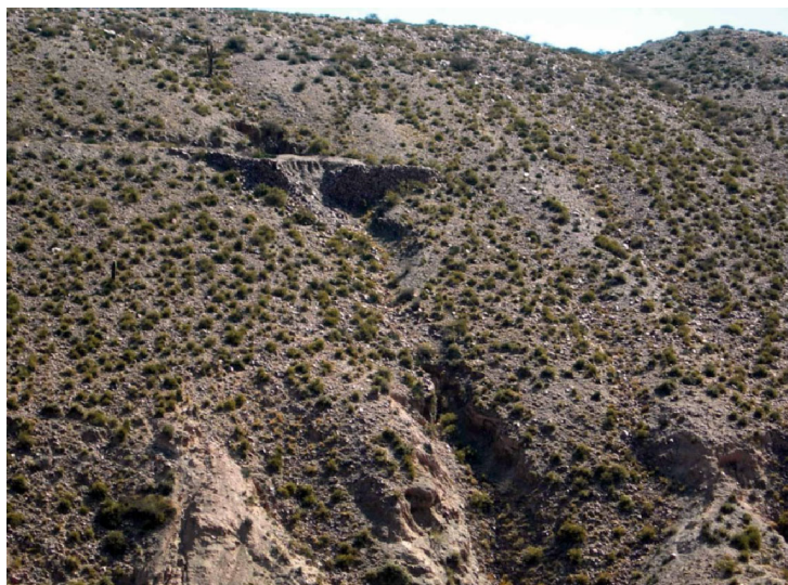
Figura 5. Tramo de camino elevado hacia El Churcal.
