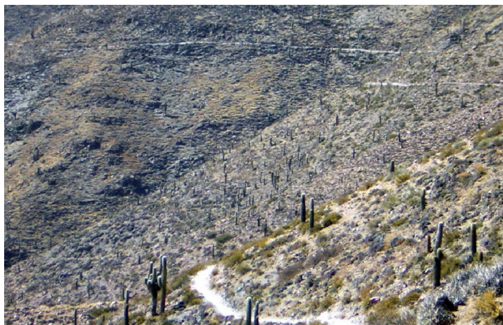
Figura 13. Camino en pendiente ondulada, con muros de contención en todo su recorrido.
