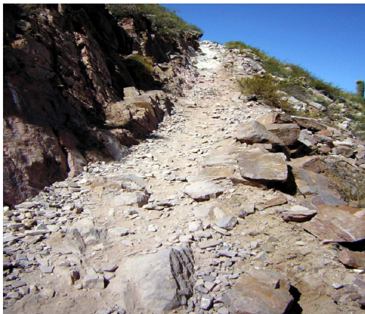
Figura 12. Camino trazado en roca madre con restos de muros de contención lateral.
