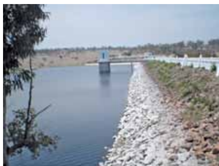
Fotografía 2. Panorámica de la presa de Valsequillo en el Estado de Puebla, México.
