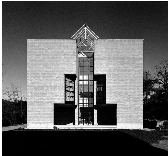
Figura 2. Casa unifamiliare a Pregassona, Svizzera (1979-1980). Foto Alo Zanetta.
