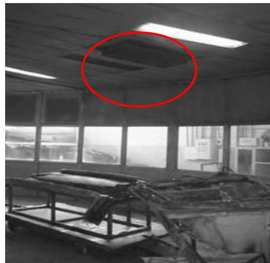
Figura 1. Boquilla de combustión para curado de piezas
