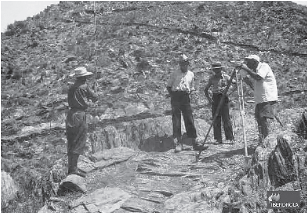
Figura 1. Trabajos de triangulación (AHISA).
