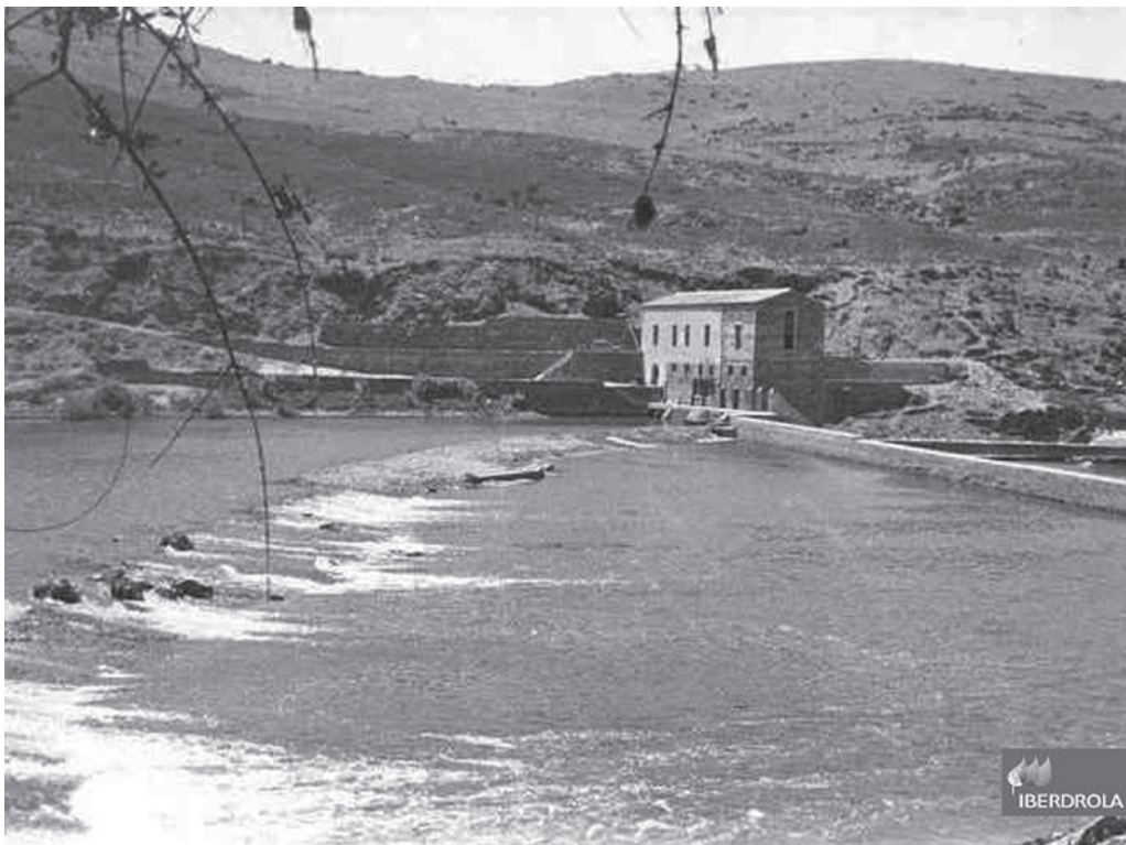
Figura 3. Vista de la Central de Pitarch desde la margen derecha: Aceña, presa y pesquera (AHISA).
