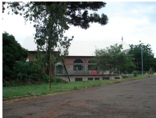
Figura 4 – Edificações na APP.
