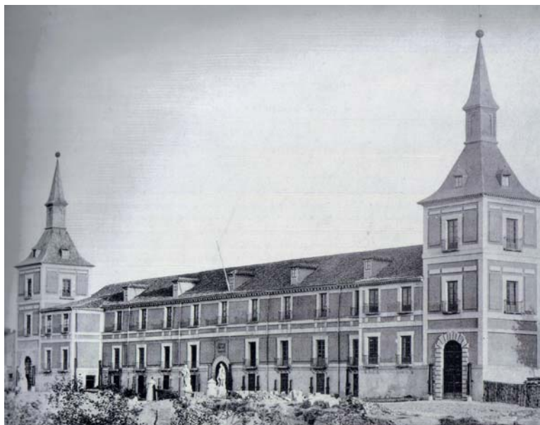
Fig. 10. Fotografía del estado del edificio tras el proceso de reforma planteado en 1874
