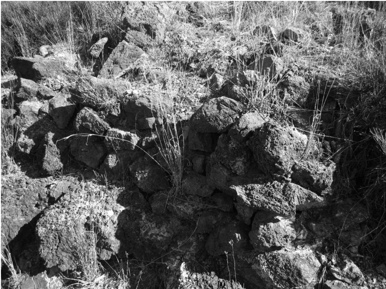
Figura 4. Mina Geminada. Estructura exterior.
