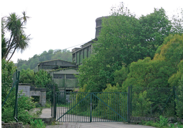
Figura 2. Fotografía del tramo accesible de la calle Ramón Izaguirre, en Langreo, Asturias (la parte edificada más alta corresponde a la antigua torre de refrigeración de la Sociedad Ibérica del Nitrógeno).
